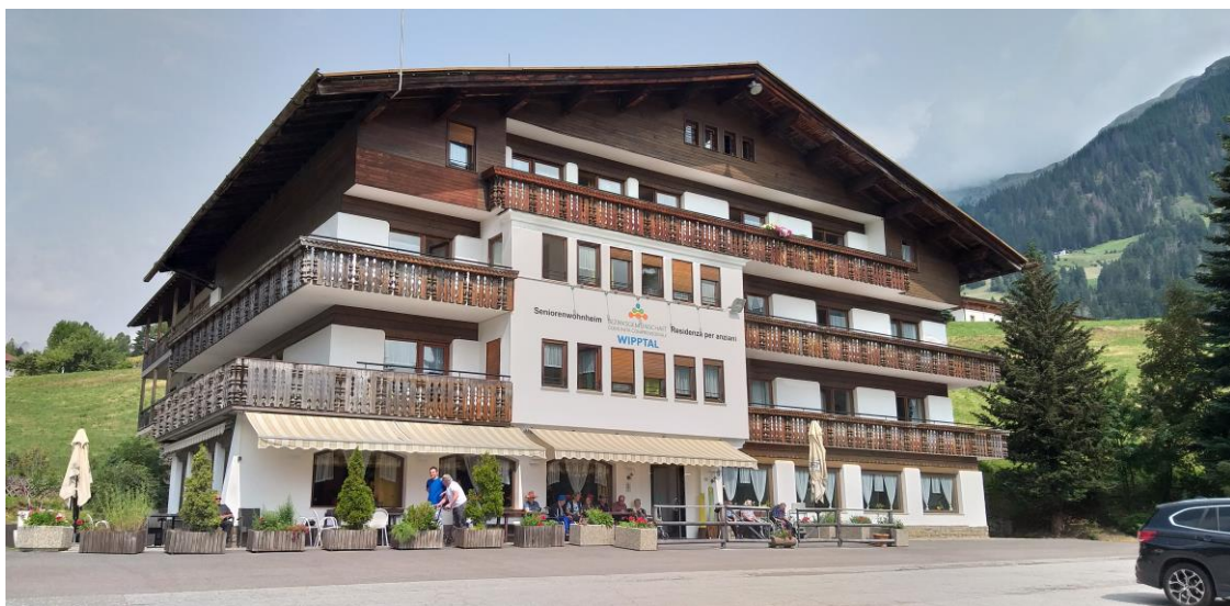
Die Übergangsstruktur des Seniorenwohnheimes Wipptal „Pulverer“ in Mareit gibt ein einladendes Bild.
